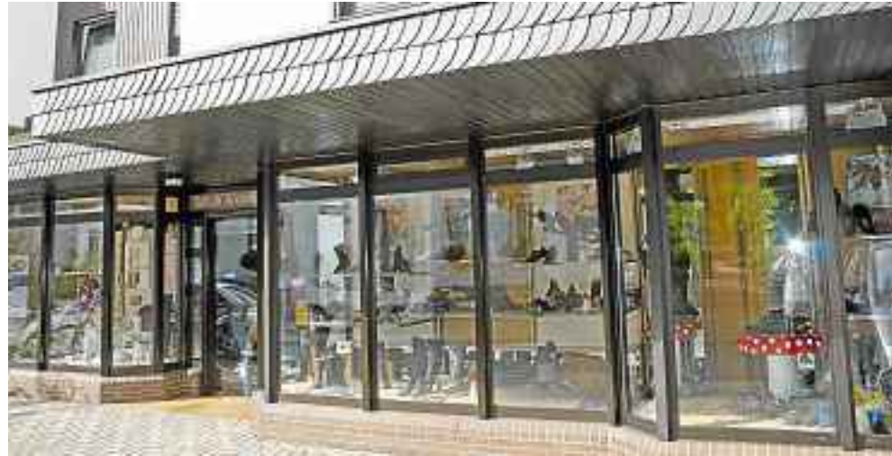
Von Oktober 2011 bis jetzt gingen die Handwerker im Schuh-Sporthaus Busiek ein und aus. Am morgigen Samstag wird die neue Praxis für Orthopädie-Schuhtechnik im Anbau eröffnet.
